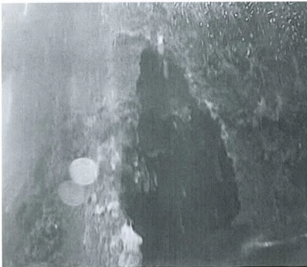
Tæringargat á útbaki stálþilsplötu
