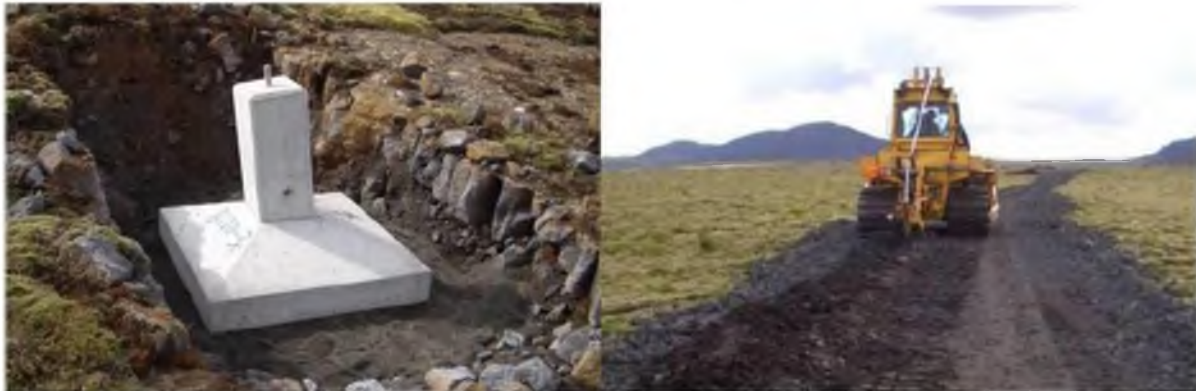
Mynd 4 Til vinstri má sjá forsteyptra undirstöðu M-masturs og hægri sést hvernig jarðskaut er plægt í vegslóð.
