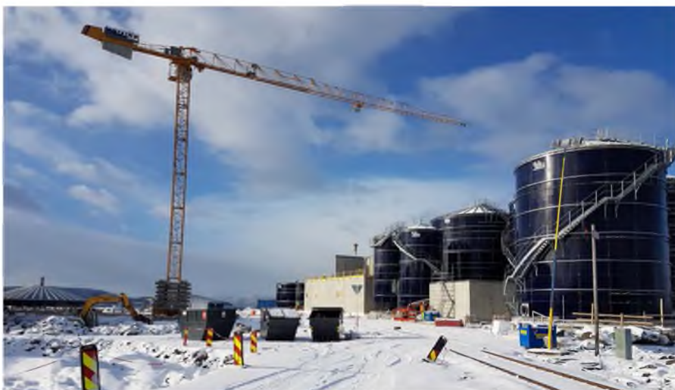
Fra byggingen av Biokraft-fabrikken på Skogn, som skal stå ferdig høsten 2017.
