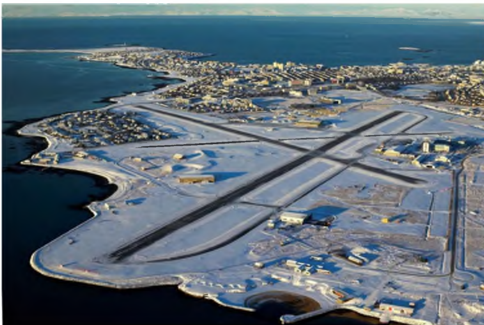
Mynd 1. Reykjavíkflugvöllur eftir endurbyggingu flugbrauta árið 2001.
