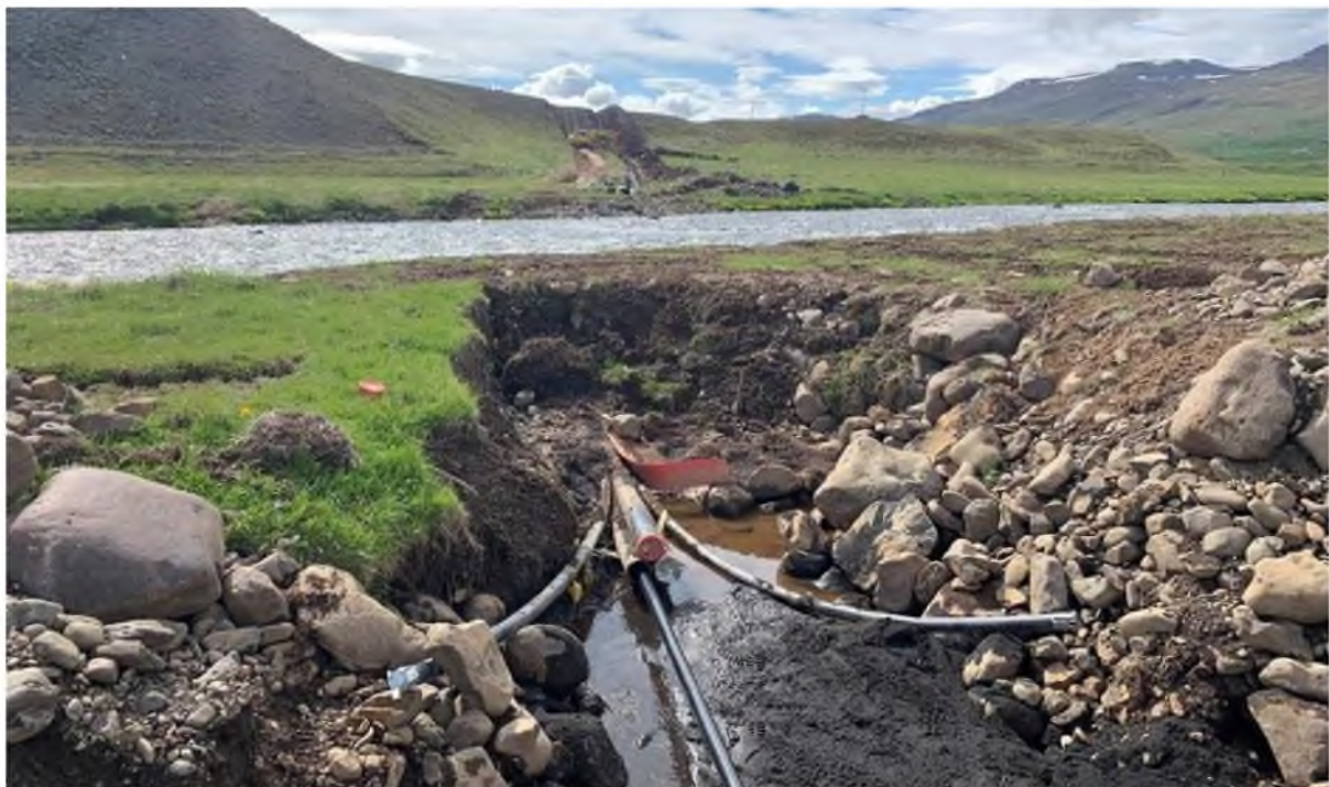
Mynd 25. Frá framkvæmdum við lagningu Sauðárkrókslínu 2 sumarið 2020. Mynd, Landsnet. Lokaorð nefndarinnar
