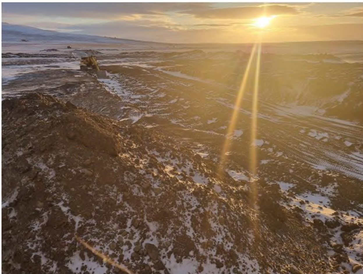
Mynd 1. Framkvæmdir við nýjan Þverárjallsveg hafnar í janúar 2022. Framkvæmdir var sameiginleg áhersla sveitarfélaga á Norðurlandi vestra í Samgöngu- og innviðaaætlun landshlutans frá árinu 2019. Mynd, Guðmundur Haukur Jakobsson.
