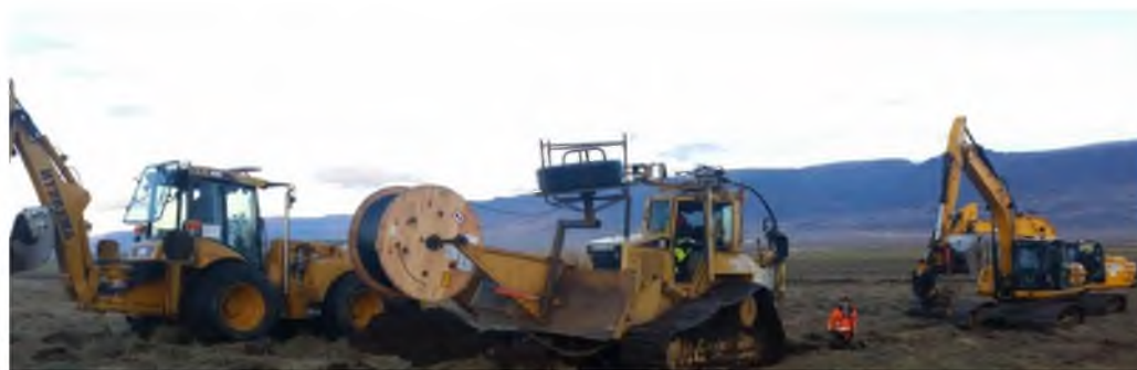
Mynd 17. Frá lagningu ljósleiðara í Skagafirði. Mynd, Sveitarfélagið Skagafjörður
