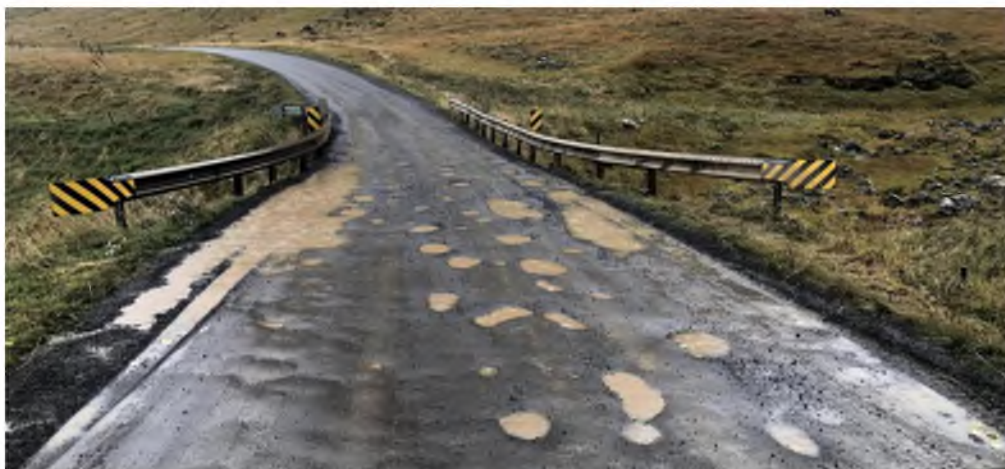
Dæmigert ástand malarvega á blautu hausti, mynd tekin á Skarðsströnd (Klofningsvegi)
