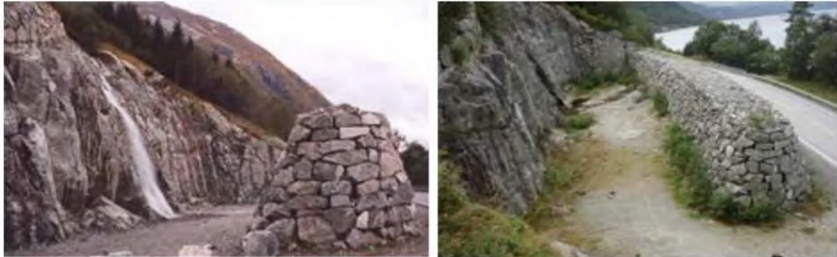
Figur 8.29 Foto av fangvoll med bratt tørrmur på begge sider, Rv. 7, Indre Rotagjelet, Hordaland. Foto: H. Norem
