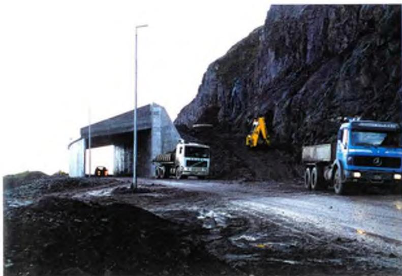
Mynd 22: Vegskáli í byggingu á Ófæru með stiga á Óshlíð 1994.
