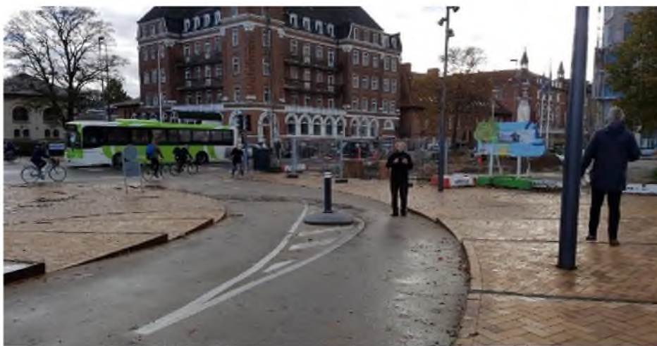
MYND 64 Varúðarmerking um 10 m áður en komið er að hindrun á stíg og endurskin á staur. Hindrunin er ætluð til að loka fyrir akandi umferð bifreiða. Hjólastígur í Óðinsvéum, Danmörku.
