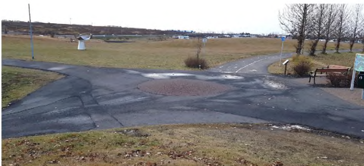
MYND 49 Hringtorg á mótum stíga. Miðeyja mótuð með litaðri steinlögn sem hækkar að miðju. Lýsing mætti vera betri.
